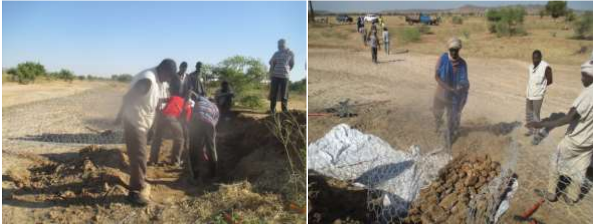
Construction de digues filtrantes à NDoumolly
